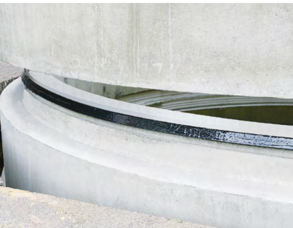
elementy łączone za pomocą uszczelki
