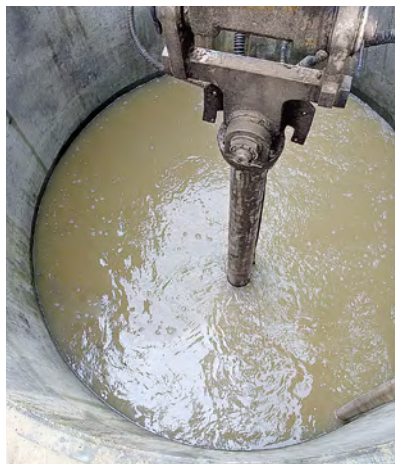
betonowanie korka podwodnego
