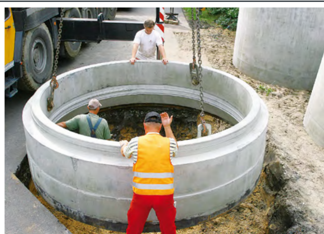
Łatwy montaż za pomocą specjalnych kotw systemu DEHA
