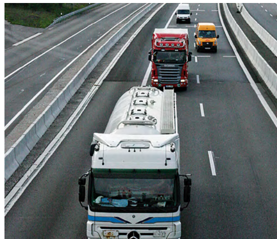
Węzeł Autostradowy Weinsberg
