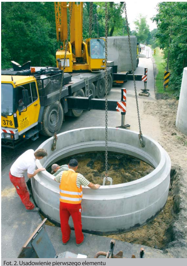
Fot. 2. Usadowienie pierwszego elementu
