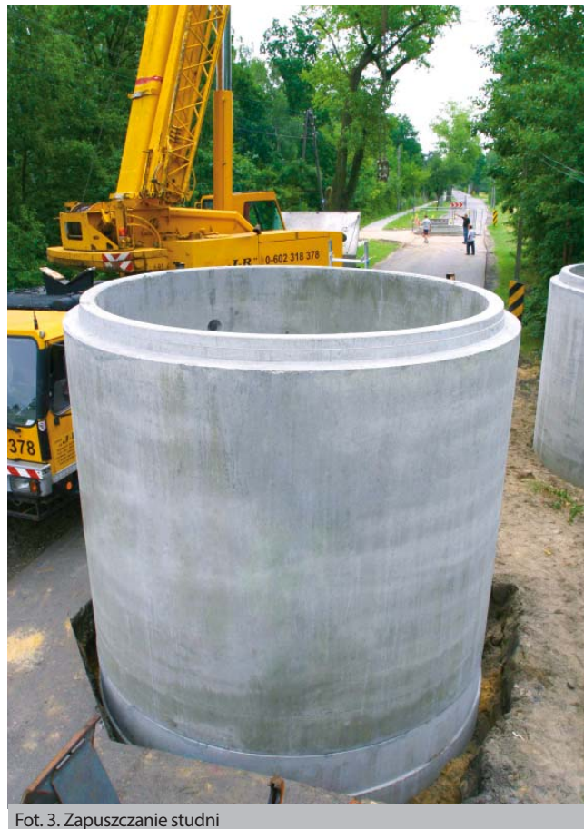
Fot. 3. Zapuszczanie studni
